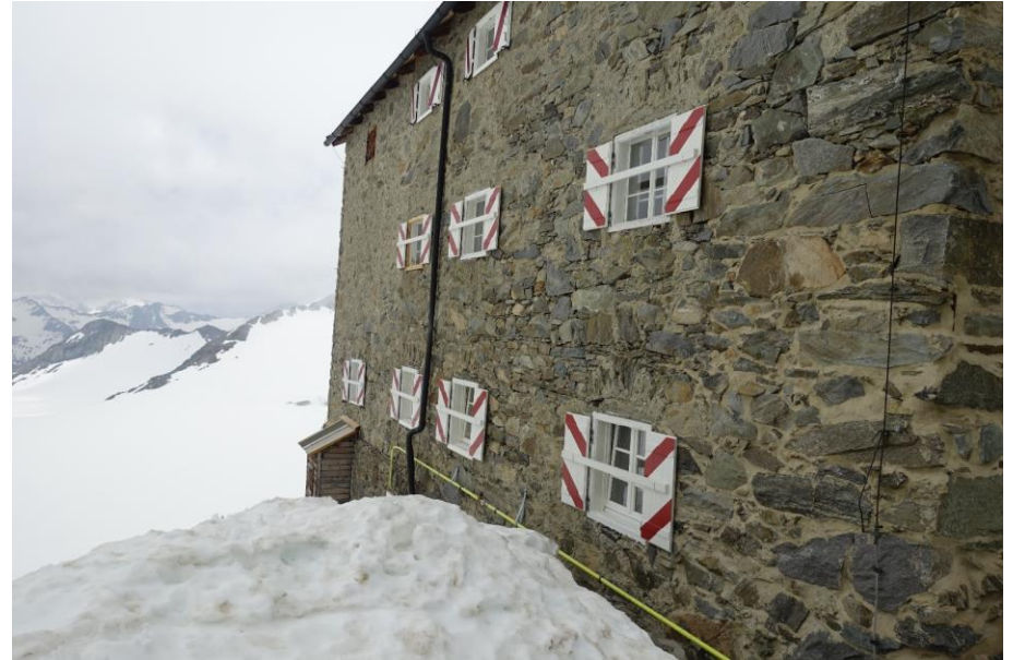
Brandenburger Haus (Ostseite) – Fensterläden im 1. + 2. OG ersetzt
